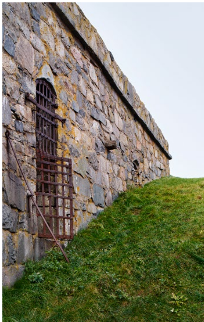
Nya Älvsborgs murar har alltid varit oputsade, därför påminner dagens utseende i allt väsentligt om det som mötte fästningens soldater redan på 1600-talet.
