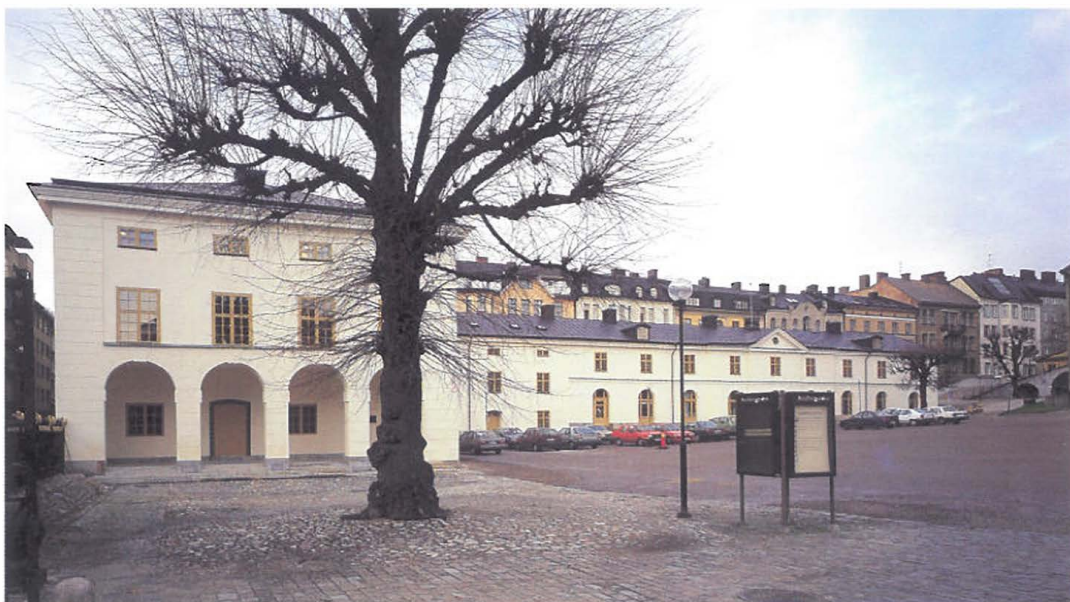
Armémuseum i Stockholm är en av många SFI-byggnader som genomgår stora renoveringar. Båda flyglarna har grundförstärkts och totalrenoverats in- och utvändigt. Uppfartsramperna till huvudbyggnaden har lagts om och nu återstår en helrenovering av tyghuset, dvs själva museibygnaden. Armémuseum är inrymt i Artilleri-gården vid Riddargatan, som byggdes 1763-1806. Huvudbyggnaden förhöjdes med en våning 1884.
