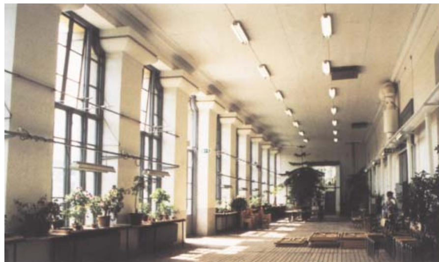
Under sommaren är orangeriets växter placerade utomhus. Rummet präglas då av södra fasadens murpelare med sina kraftigt utskjutande kapitäl, som till hälften kragar in i rummet.
