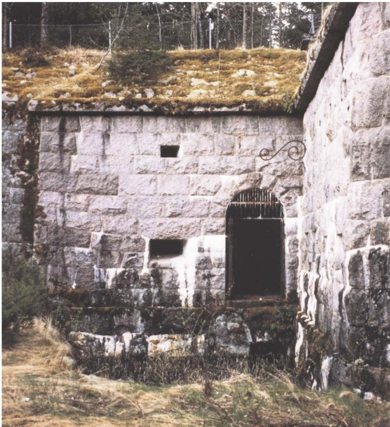
Väbergets fästning, landets första i berg insprängda fästning, började byggas 1889 och var försvarsduglig 1902. Redan efter 25 års tjänst hade utvecklingen lämnat fästningen långt bakom sig och anläggningen, som aldrig blev riktigt färdig, lades ner. Bilden är tagen i graven och visar en flankeringskaponjär i kontereskarp-muren.
