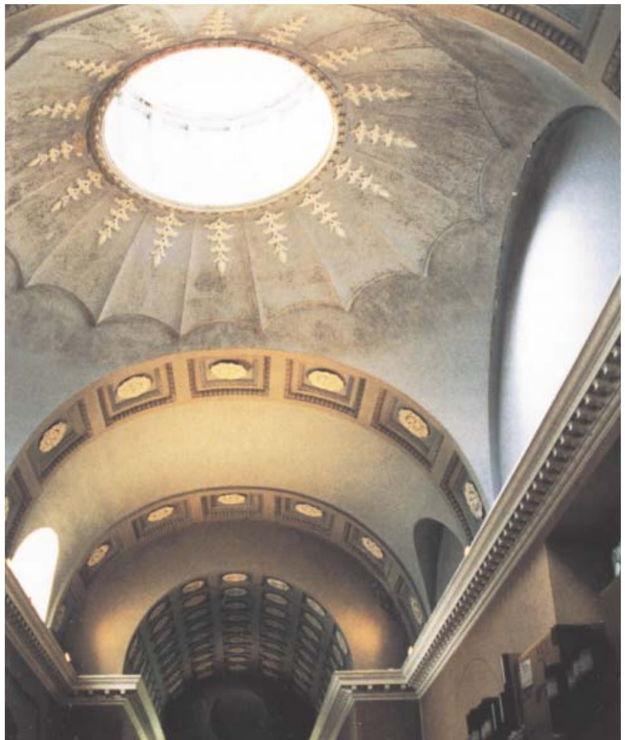
Linnésalens mittparti har en kupol med överljus från en lanternin, som ger en pantheonliknande ljuskägla på väggen till höger.
