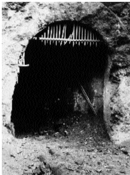
Skadorna efter en 22 cm granat som detonerats framför en kontereskarptunnel. Bilden är från 1904.
