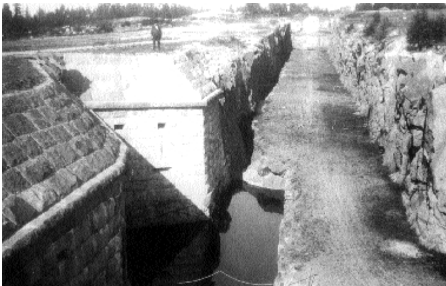
Södra fortets frontgrav från söder. Till vänster det dubbla kontereskarpgalleriet och bakom mannen skimtar de två Nordenfelttornen och till höger, på andra sidan graven på fort kärnan, syns ett av de höj- och sänkbara Finspångtornen. Fotot lär vara från 1910.
