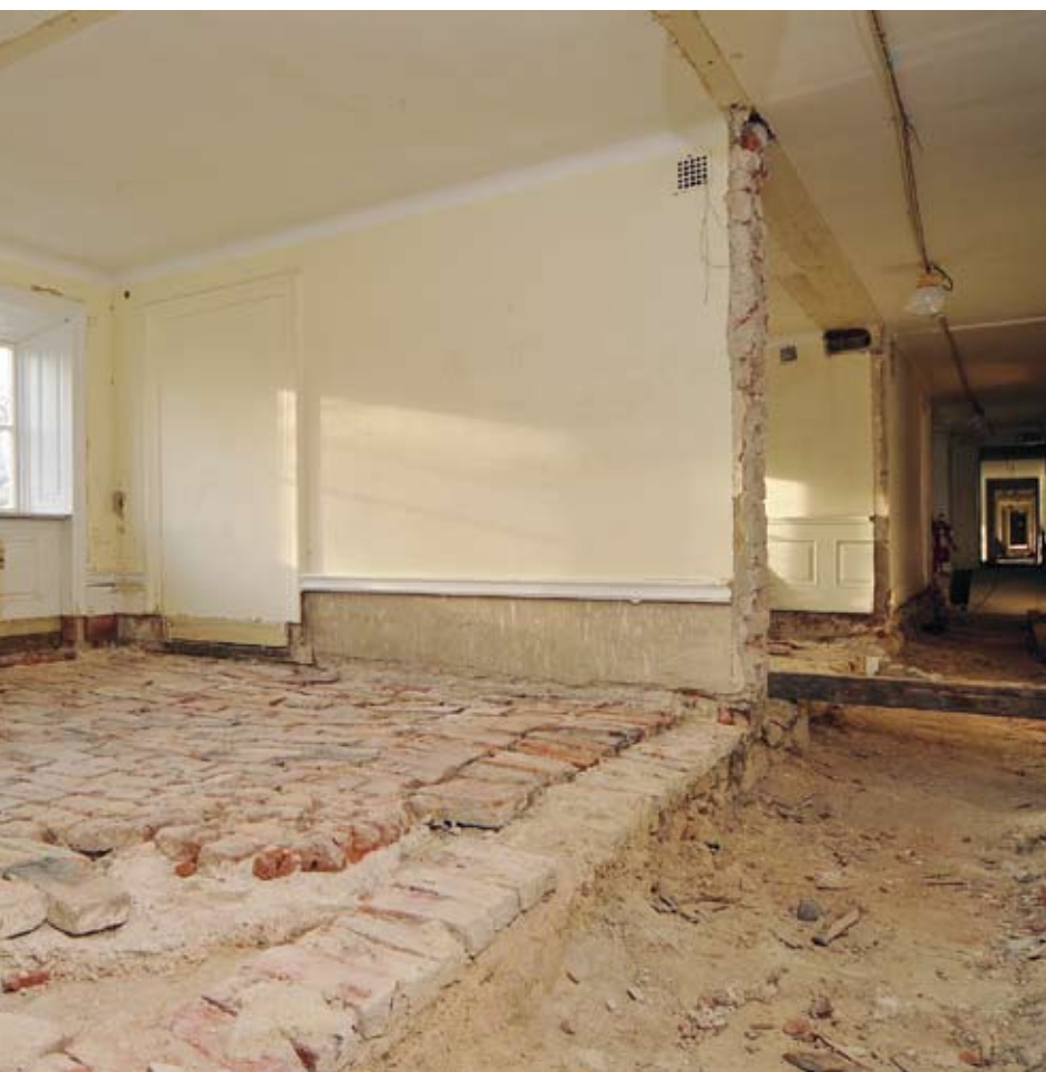
Under golvet i den långa korridoren finns en naturlig ficka som gjorde det möjligt att gömma ledningar. Tegelgolvet är byggt med stenar från bland annat Svartsjö slott.
