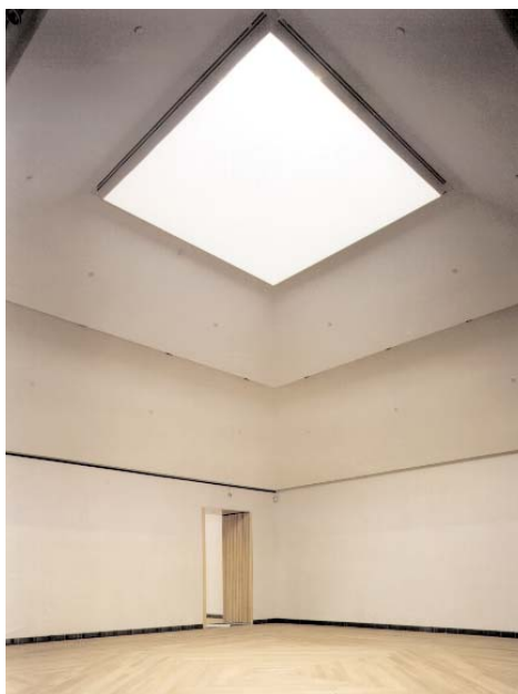
De rymliga utställningssalarna för den permanenta samlingen har alla kvadratisk planform och får sitt överljus från takets lanterniner. Ett elektroniskt reglerat ljusinsläpp bidrar till en jämn belysning året om.
