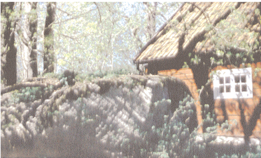
Ladugården byggdes på 1920-talet men i den kan ingå delar av en äldre ladugård.
