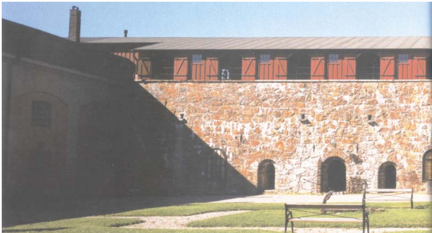
Rekonstruerade fredstak och skorstenspipor över Norra huvudvallen, Bastion Apollo och Östra huvudvallen.
