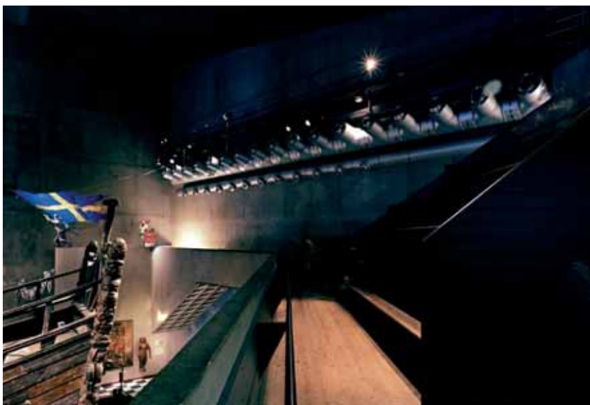
Luftdonen längs västra väggen ser till att skeppets akterparti har rätt klimat.
