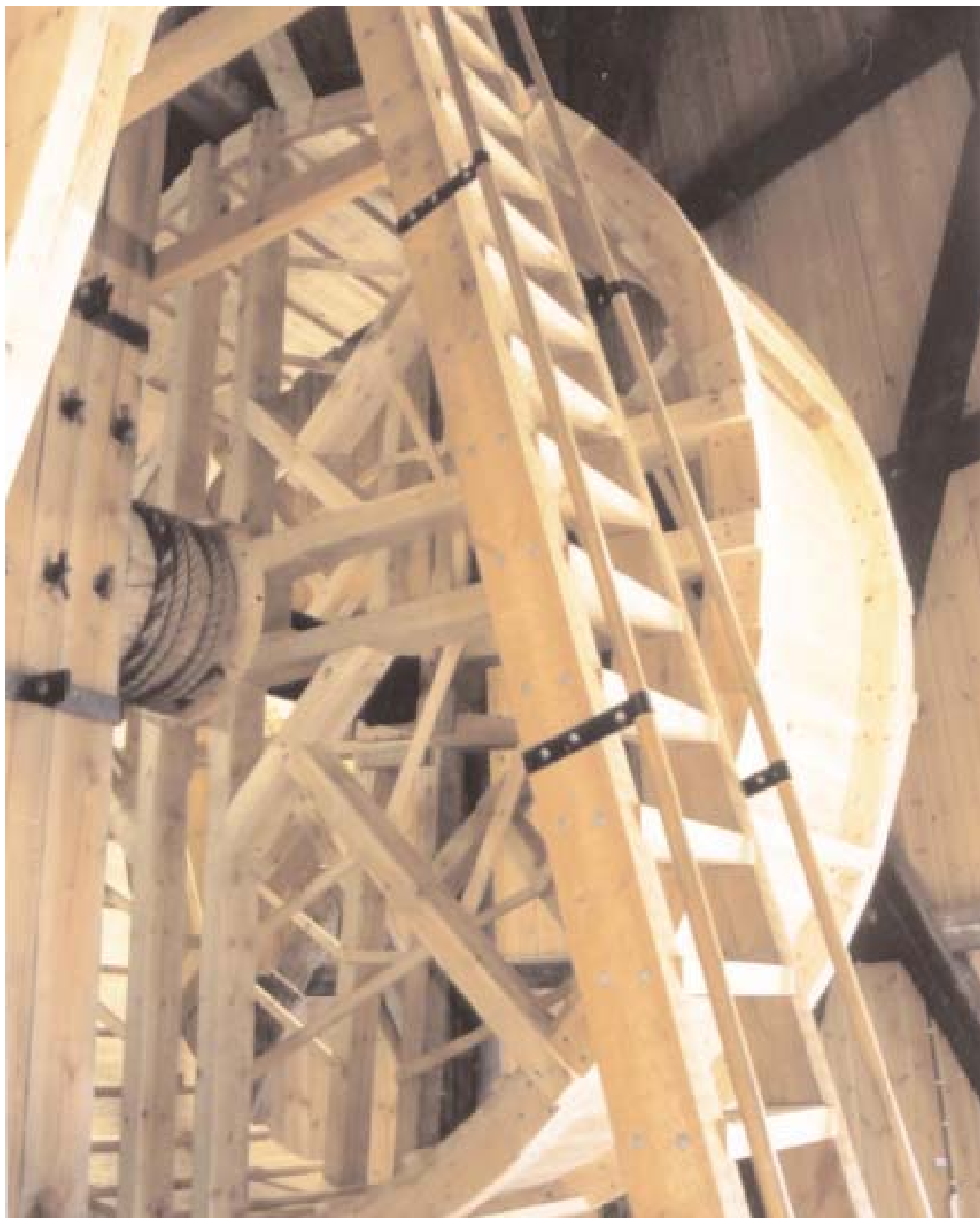
Kranens 'maskineri' har tillverkats av utvalt virke från Venjans såg i Dalarna.
