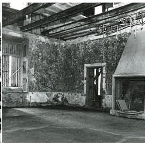
1970-talets betonggolv och stålbalkförstärkningar.
