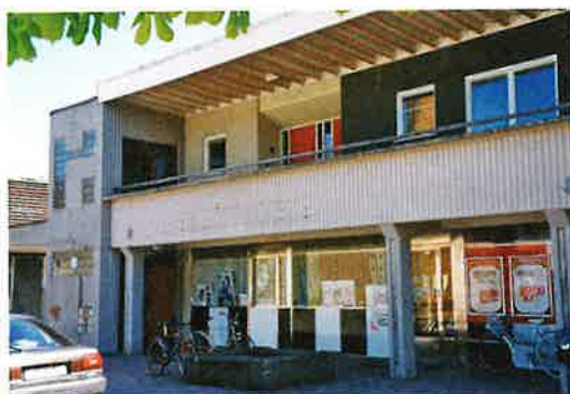
Fasaden har lyfts fram på hissutbyggnaden. Det gamla trapphusets ljusinsläpp finns kvar som blindfönster på den nya fasaden.
