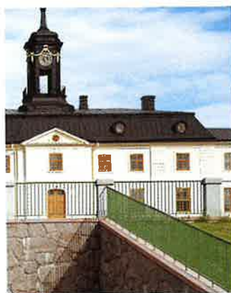
Den återuppförda rampen och den återställda fasaden.
