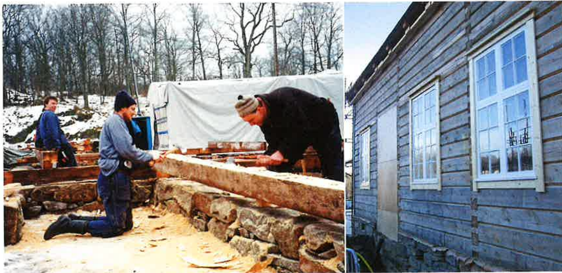
170 år efter att de brunnit byggdes de båda flyglarna upp igen efter originalritningarna och med traditionella material och metoder.
