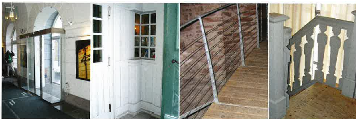
Tillägg i form av vindfång har lösts på olika sätt. Till vänster vindfång på Stockholms stadsmuseum, arkitekt White arkitekter. Till höger vindfång vid entrén på Katarina kyrka, arkitekt Ove Hidemark.
