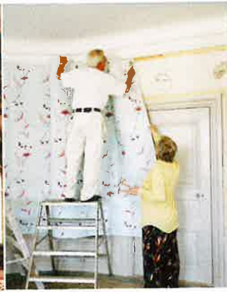
Montering av tapeter på trälister.
