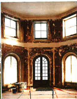
Salongen under restaureringsarbetet.
