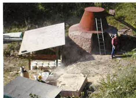
En kalkugn byggdes 1996 strax söder om slottsruinen för framställning av murbruk ur ölandskalken – det material slottet ursprungligen murades av.
