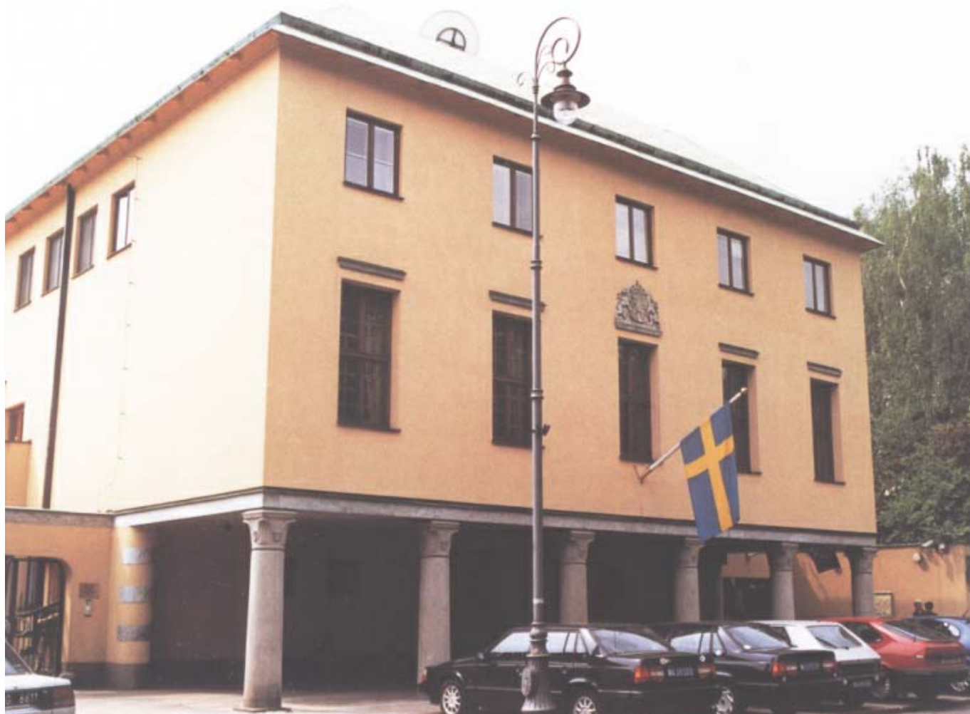
För två år sedan fick ambassaden i Warszawa en ny fasad. Den förra var grå och sliten.
