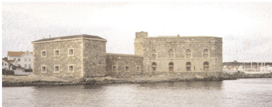
Södra strandverket från söder. Strandverket byggdes 1851–55 för att säkra det södra inloppet till Marstrand. En viktig orsak var att fästningens skottlinjer på grund av berget hade svårt att nå strandlinjen.
