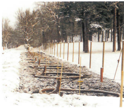
De nya växtbäddarna är 5 m breda och 80 cm djupa. Runt varje träd läggs en dränerings- och bevattningsledning.
