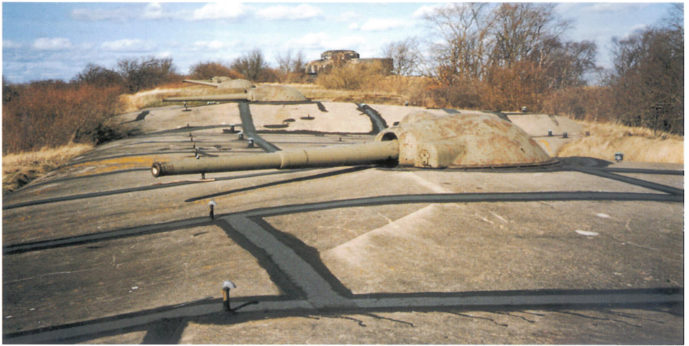
Södra batteriets 12 cm kanoner under pansarkupoler tillkom vid ombyggnaden 1901–05.
